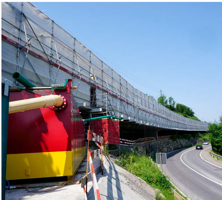
Des remblais suffisamment stables ont dû être réalisés pour les IPE.
