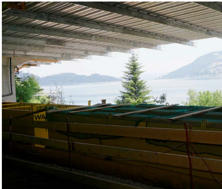
Ce chantier de Küssnacht-Arth est particulier du fait que les IPE, sont à proximité immédiate du lac de Zoug.
