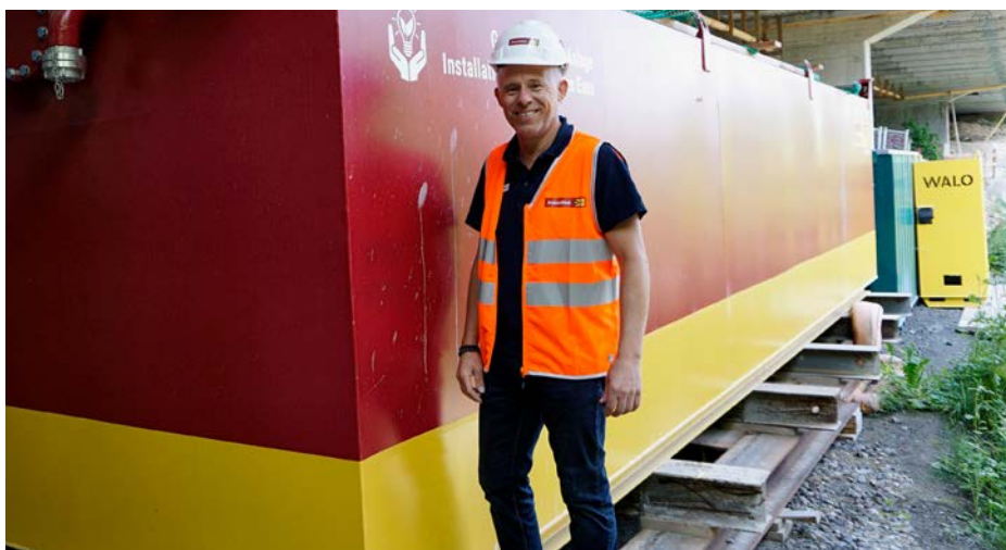
Renato Müller, chef du projet d'IPE chez Avesco Rent, a mis en place les installations de protection des eaux à Küssnacht-Arth.
