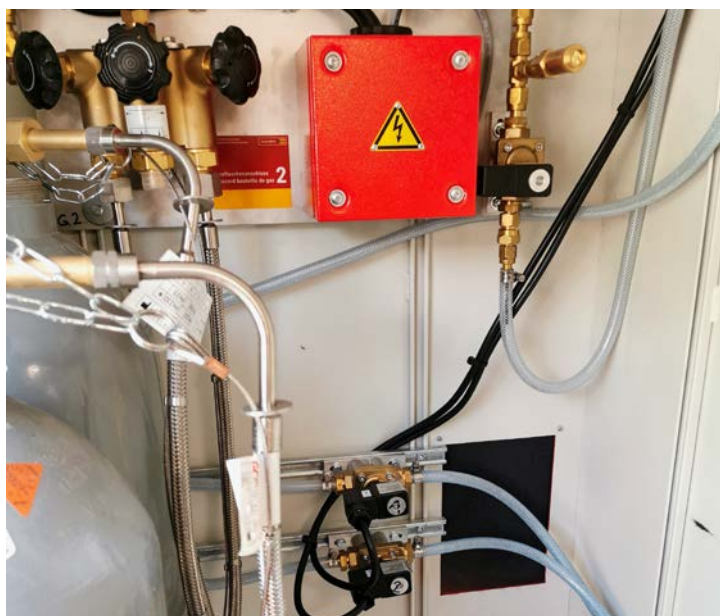
Alimentation en CO 2 fiable : lorsqu'une bouteille de gaz est vide, le système passe automatiquement de l'autre côté de l'alimentation en gaz.
